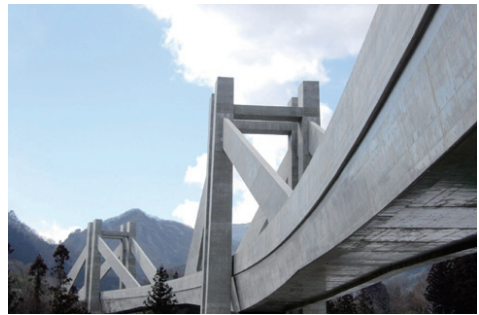
施工例：群馬県長野原町の「第二吾妻川橋梁」
